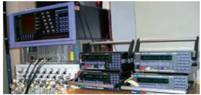
Bild 2: Messaufbau zum Erfassen der Momentanleistungen sowie der Energieverbräuche von Einzelkomponenten der Klimaanlage.
